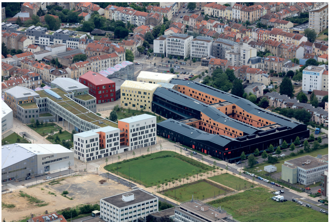
Vue aérienne de l'UL - juin 2018 © Solorem
